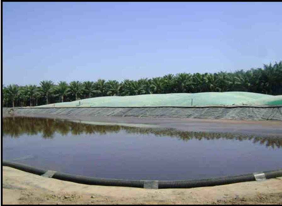
Lagunas de Oxidación, al frente sin cubierta; al fondo con la cubierta ya instalada.
